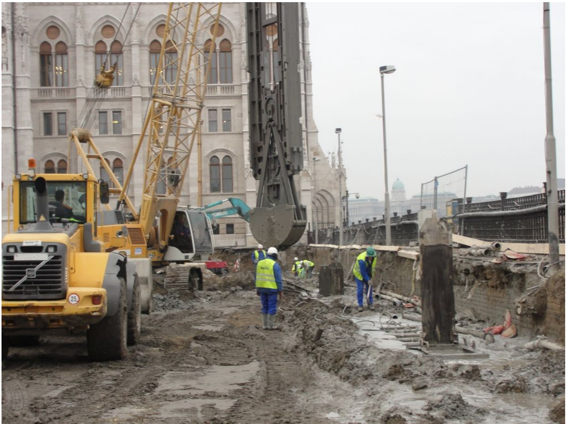
Kivitelezés geodéziai munkái 1. Mélyépítés Mérnökgeodézia 4. előadás BME Általános- és Felsőgeodézia Tanszék
