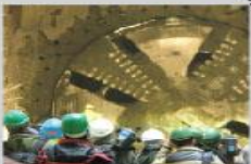
Az alagút-fúró pajzs megakadályozása a Bocskaiban Metro-4 alagúton
