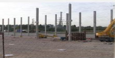
A pillének függőlegességének ellenőrzése szírnén a geodéziai feladatok (balra)
