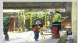
Fúrópajzs átérési helyének kitzűzése a Metro-4 alagúton
